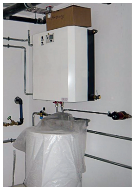
Hausanschlussstation (HAST)
